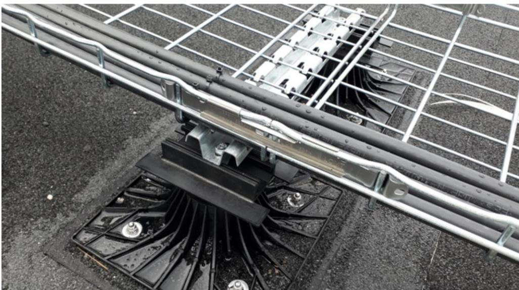
**Figure 19 : Plots FIX EVO supports de chemin de câble**
