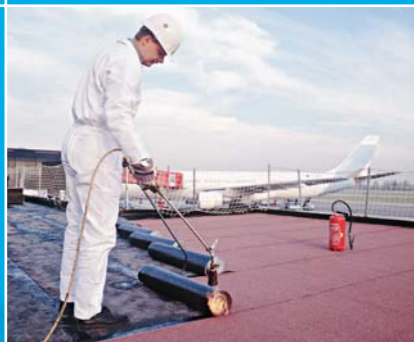
Mise en œuvre de l'étanchéité par soudure Aéroport Strasbourg Entzheim
