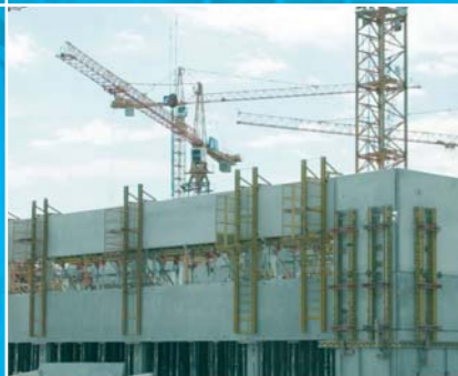
Chantier Hôpital Civil de Strasbourg 22 000 m 2 d'étanchéité
