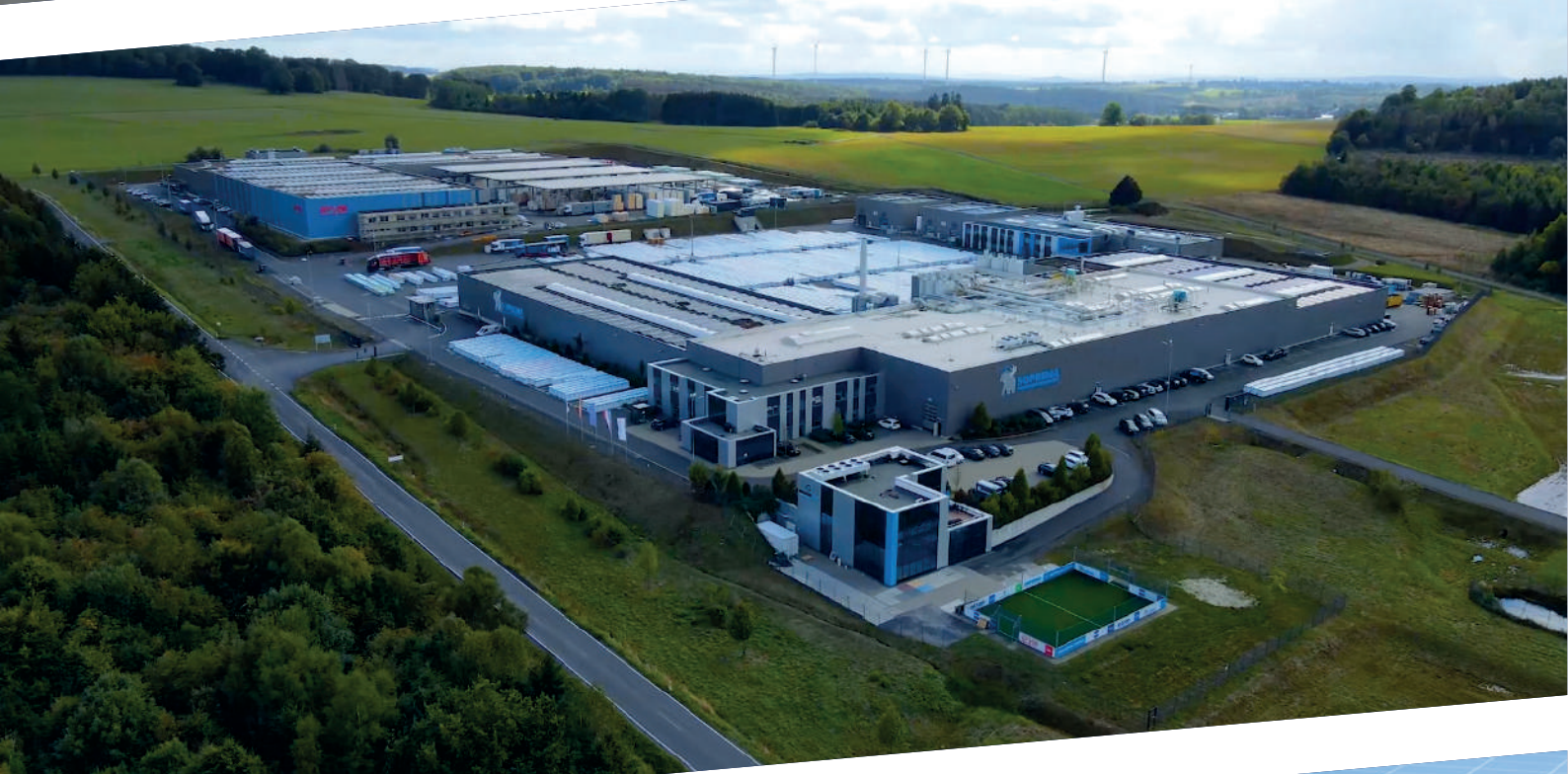
Usine de Hof (Allemagne) © SOPREMA
