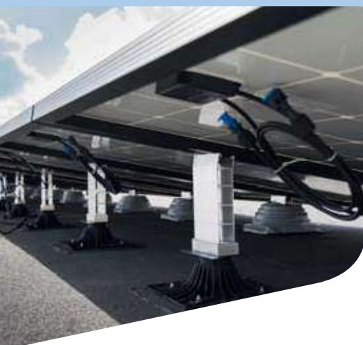
**SOPREMA vous propose, par le biais de sa filiale SOLARDIS, la solution performante pour aménager les toitures-terrasses d'équipements techniques sans risquer de dégrader l'étanchéité de la toiture grâce à son nouveau plot Soprasolar® Fix Evo.**
