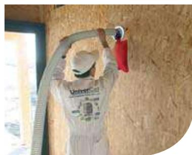
L'insufflation consiste à injecter pneumatiquement sous pression et à sec les fibres dans une paroi verticale.
