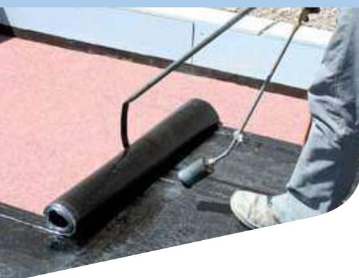
On parle de bitume élastomère quand le bitume est modifié à l'aide de matières synthétiques ou de polymères du type Styrène-Butadiène-Styrène (SBS). La qualité du bitume élastomère est fonction de la qualité des élastomères ajoutés et de la maîtrise du processus de mélange.
