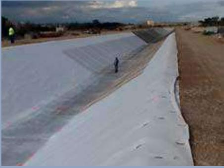
**Géotextiles non tissés aiguilletés 100 % polypropylène, utilisés principalement comme protection mécanique dans les projets d'infrastructures routières, de fondations, de bassins et d'ouvrages souterrains.**
