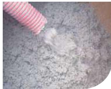
Le soufflage consiste à épandre pneumatiquement et à sec les fibres sur une surface horizontale ouverte, notamment dans les combles non aménagés.
