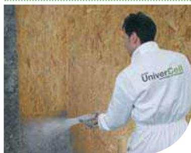
La projection humide consiste à appliquer sous pression les fibres, associées à une faible quantité d'eau pour l'isolation d'une paroi verticale.
