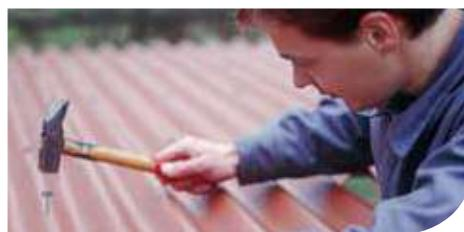
Les plaques Sopraplac ondulée sont mises en œuvre de manière similaire aux plaques Sopraplac (Mono 235 ou Duo 235). Les Faîtières Sopraplac sont posées dans le même sens que les plaques.
