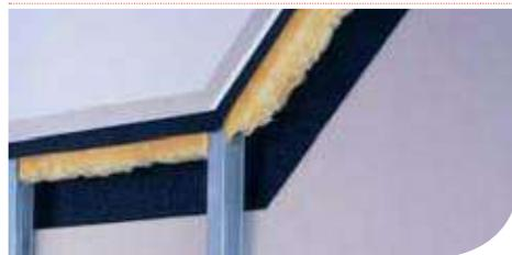
Elles peuvent être découpées au format voulu et comportent une sous face adhésive ou recouverte d'un film protecteur en polypropylène que l'on retrouve sur la surface du produit.
