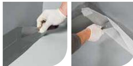
Alsan® 310 est une résine polyuréthane mono-composante, prête à l'emploi, qu'il suffit tout simplement d'homogénéiser avant application.
