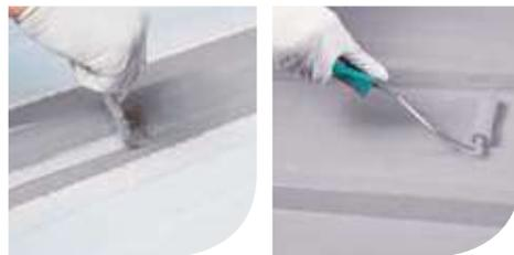
**Alsan® 320** est une résine acrylique mono-composante prête à l'emploi, qu'il suffit tout simplement d'homogénéiser avant application.
